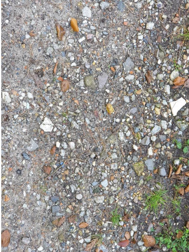
Abb. 14: eingebauter Bauschutt im Forstweg
